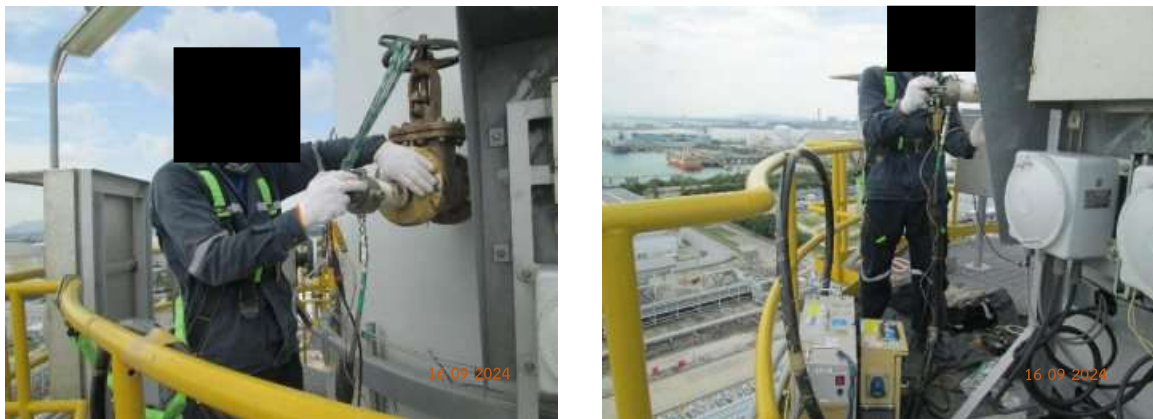
รูปที่ 2 การตรวจสอบประสิทธิภาพระบบตรวจวัดคุณภาพอากาศจากปล่องแบบต่อเนื่อง (CEMs)
